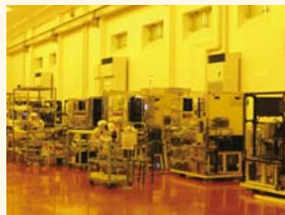
クリーンルーム
